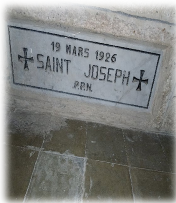
1 ère pierre de la fondation
